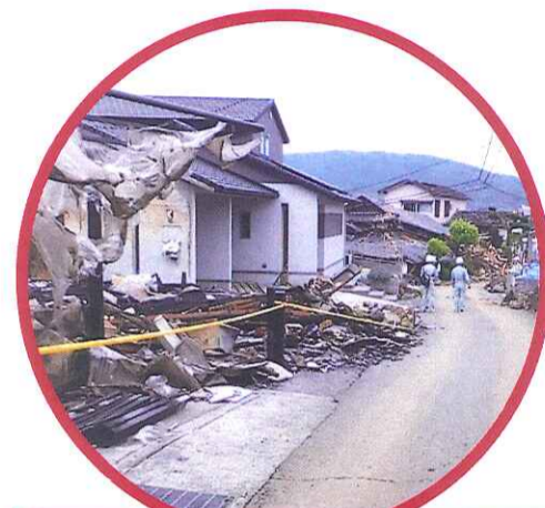
住宅の被災状況
