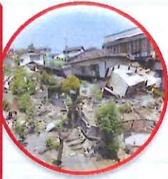
住宅の被災状況
