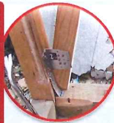
柱脚筋かい金物
